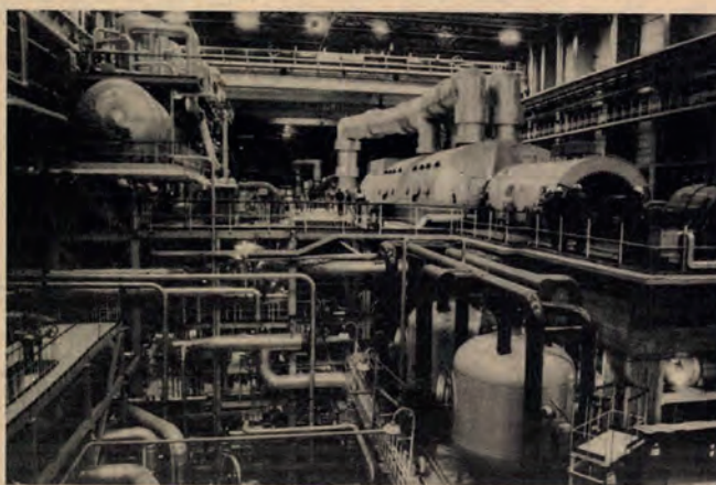
Az I-es blokk kettes számú turbina-gépcsoportja már áramot termel
