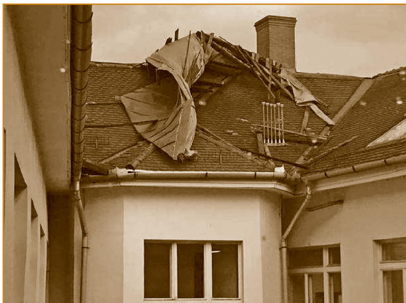
A sérült tetőszerkezet
